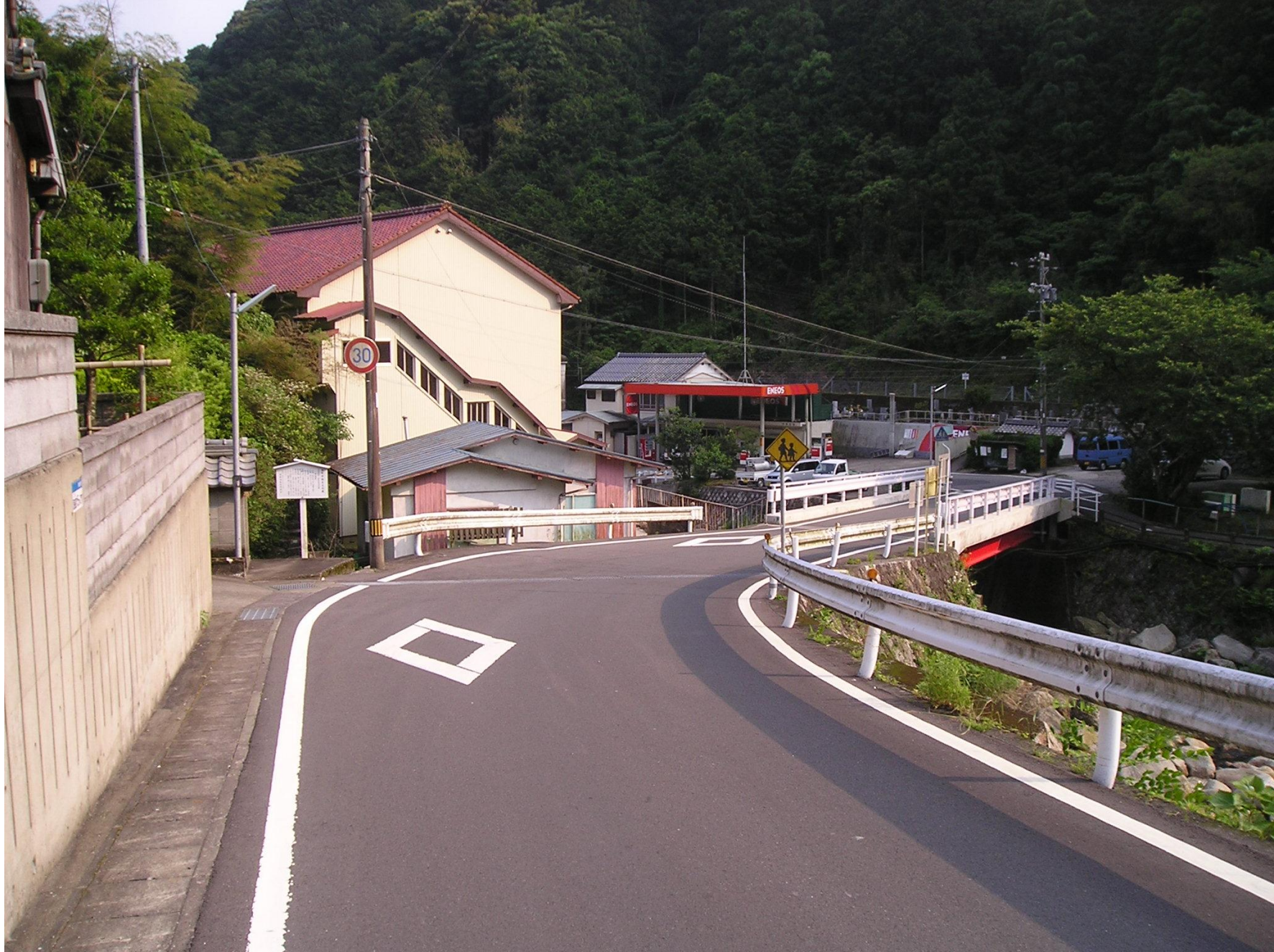
山側からみた「津浪地蔵」とその説明看板の遠景。写真中央のガソリンスタンド横の墓地入口には、1944年の「東南海大地震津波到達地点」の碑がある。
