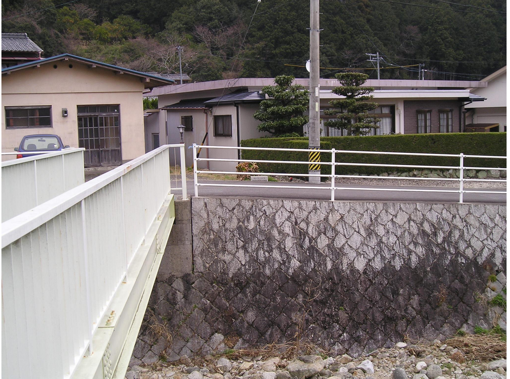
熊野市新鹿町の里川北側の道路脇(熊野市立新鹿小中学校北側付近)にある「東南海大地震津波到達地点」の碑の遠景。写真中央の電柱左側にみえるのが、津波到達地点の碑。
